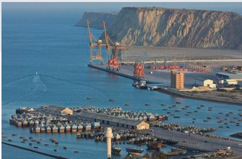
图七：中国援建的瓜达尔港项目（一期工程）位于巴基斯坦俾路支省瓜达尔镇，项目规模为新建3个2万吨级多用途泊位，结构按停靠5万吨级集装箱船设计，2002年开工建设，2008年竣工。（图片摘自网络）
